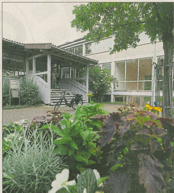
OB DAS SCHULHAUS in Stupferich in Anbetracht des Zuzugs künftig groß genug ist, steht aktuell in den Sternen. Foto: jodo
